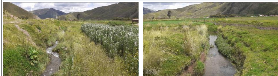
FOTO 03: Cauce colmatado y estrangulada, el cual interrumpe el normal flujo del agua, requiriendo la limpieza y descolmatación del cauce.
